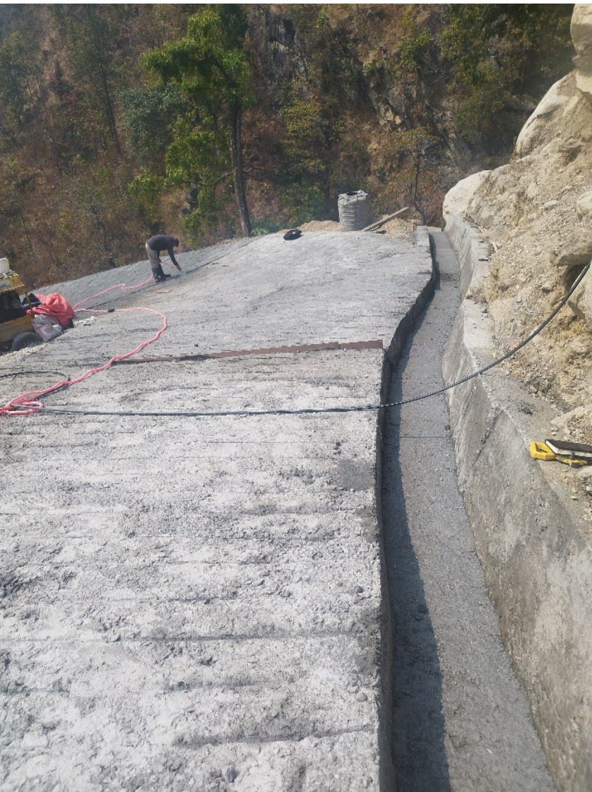
सडक ढलान तथा नाली निर्माण कार्य
